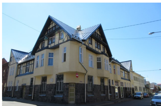
Renoveeritud korterelamu Lossi tn 35
