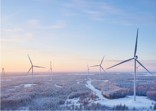
Aidu tuulepark (teostaja: Nordecon Betoon OÜ, foto: Kristian Kruuser)
