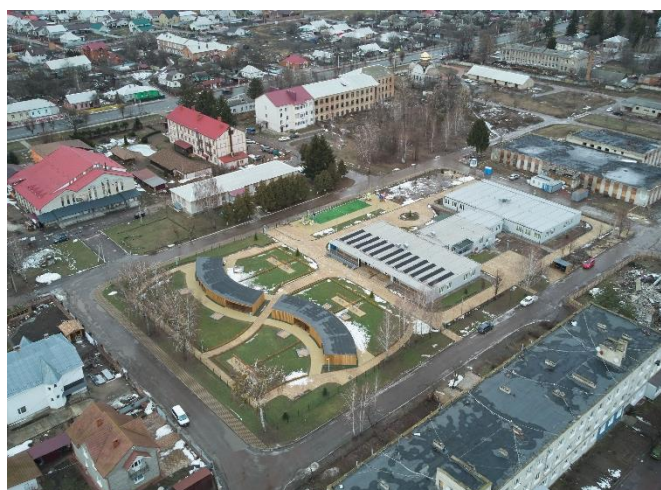
Ovrutši linna moodullasteaia I ja II etapp (teostajad: Nordecon AS ja Eurocon Ukraine TOV, foto: Eesti Rahvusvahelise Arengukoostöö Keskus SA)
