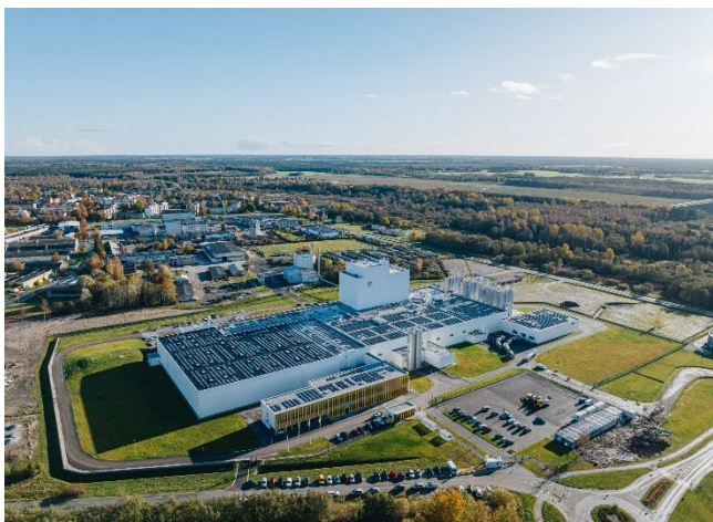
E-Piima tootmishoone (teostaja: Nordecon AS, foto: Tõnu Tunnel)
