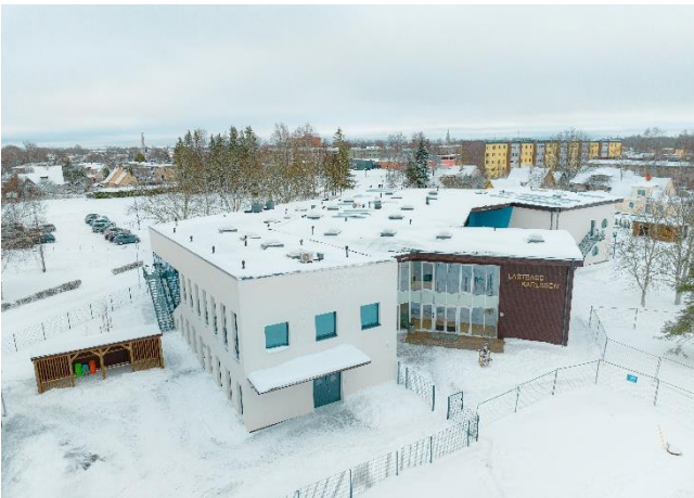
Viljandi lasteaed Karlsson (teostaja: Embach Ehitus OÜ, foto: Timo Arbeiter)
